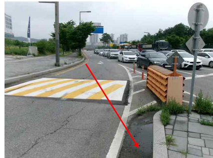
<송수-1,2 (Sta.17+3.1) 포장 및 지반 상태양호>
