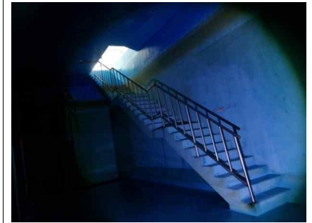
<배수지 4지 출입계단 및 안전난간 상태양호>
