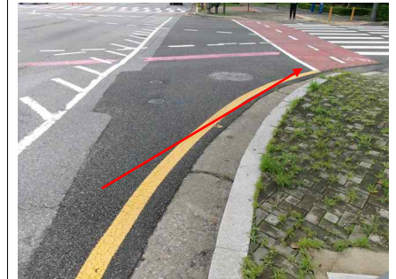
<송수-6 (Sta.0+0.0) 포장 및 지반 상태양호>
