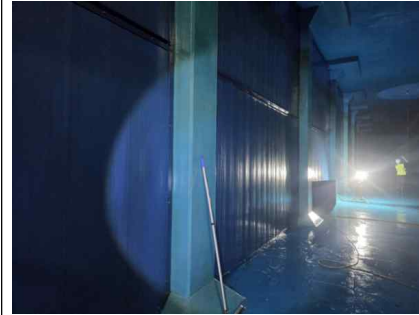
<배수지 1지 도류벽 상태양호>
