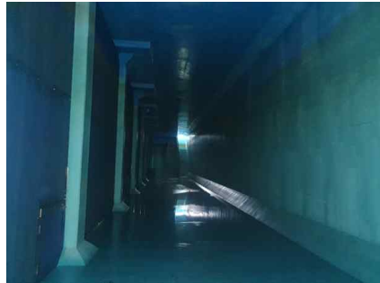
<배수지 4지 전경>
