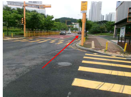
<송수-3 (Sta.10+14.3) 포장 및 지반 상태양호>
