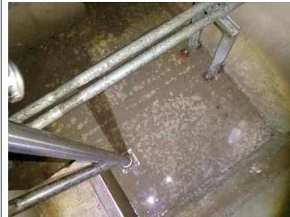
<유입배관실 바닥슬래브 채수>
