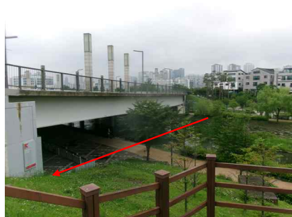
<송수-1, 2 (Sta.66+1.0) 포장 및 지반 상태양호>
