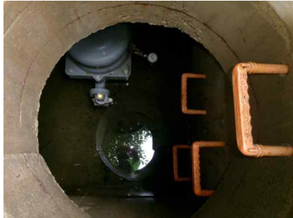
<송수-2 Sta.29+0.0(공기) 구조물 및 밸브 상태양호>
