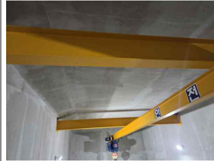
<3~4호지 유입밸브실 상부슬래브 전경>
