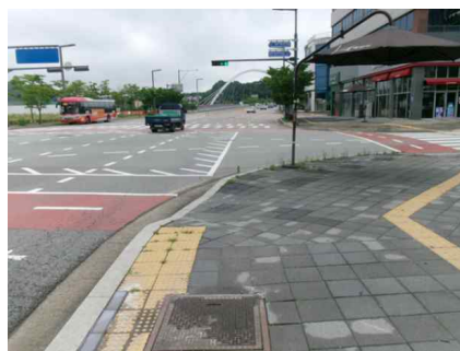
<송수-4, 5 (Sta.315+6.0, Sta.36+16.0)>
