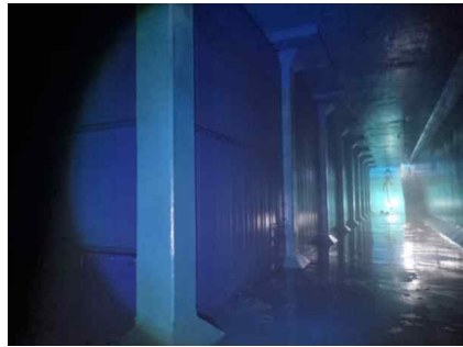
<배수지 2지 도류벽 상태양호>
