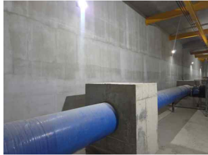
<1~2호지 유입밸브실 배관받침 상태양호>
