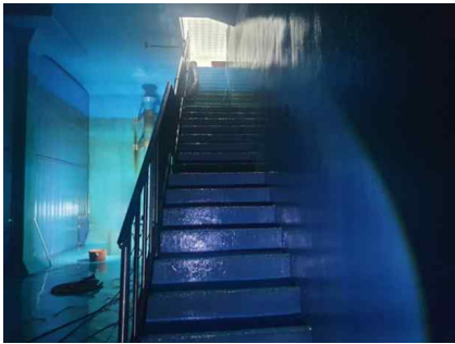
<배수지 2지 출입계단 및 안전난간 상태양호>
