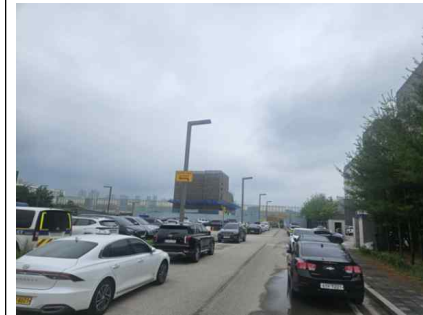
<송수-4(2), 5(3) (Sta.9+30) 포장 및 지반 상태양호>
