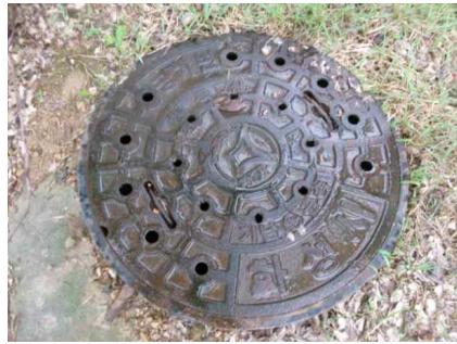
<송수-3 공기밸브실 맨홀 덮개 상태양호>
