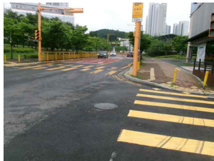
<송수-3 (Sta.10+14.3) 포장 상태양호>
