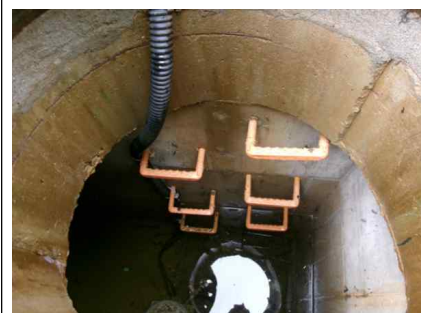
<송수-1 공기밸브실 사다리 설치 상태양호>
