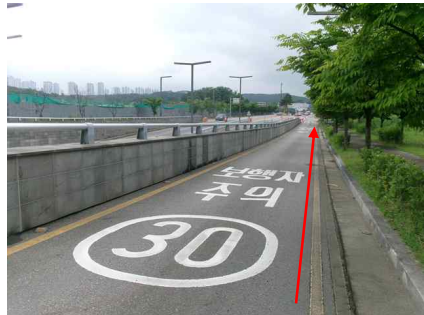
<송수-1, 2 (Sta.1+0.0) 포장 및 지반 상태양호>
