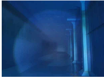
<배수지 2지 전경>
