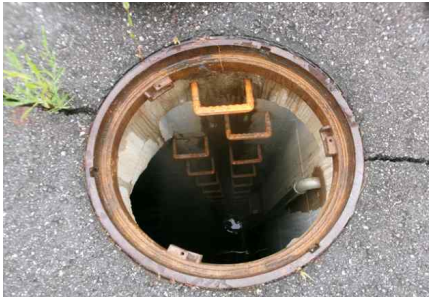
<유량계실 출입구 전경>
