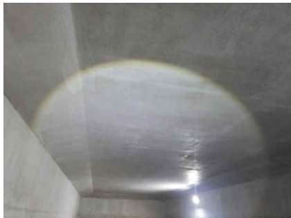
<1~2호지 유출밸브실 상부슬래브 상태양호>
