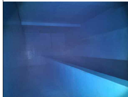
<저류조 및 흡수조 1지 내부 전경>
