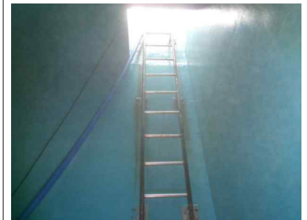
<배수지 1지 점검사다리 상태양호>
