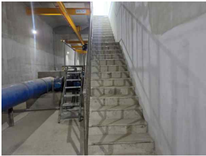
<1~2호지 유입밸브실 계단 난간 상태양호>
