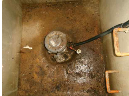
<송수-3 Sta.0+14.7(공기) 구조물 및 밸브 상태양호>
