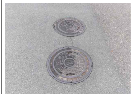
<송수-1 이토밸브실 맨홀 덮개 상태양호>
