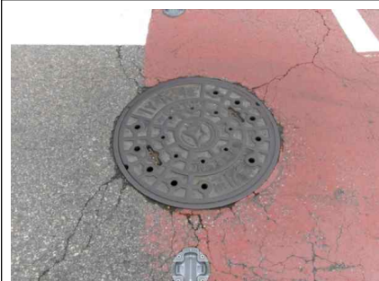
<송수-1 공기밸브실 맨홀 덮개 상태양호>
