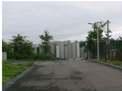
<배수지 입구부 상태양호>
