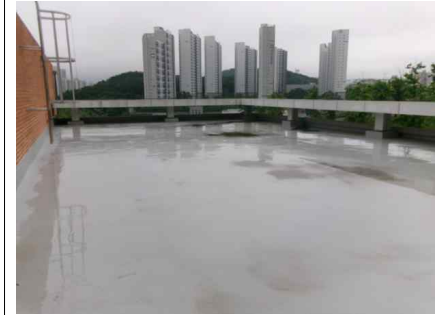
<건축물 옥상 방수층, 파라펫 상태양호>
