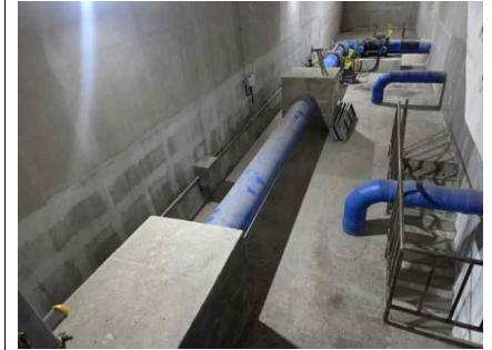
<3~4호지 유입밸브실 배관받침 상태양호>
