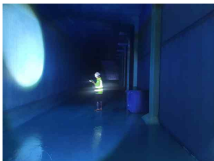
<내부 개별부재 외관조사>
