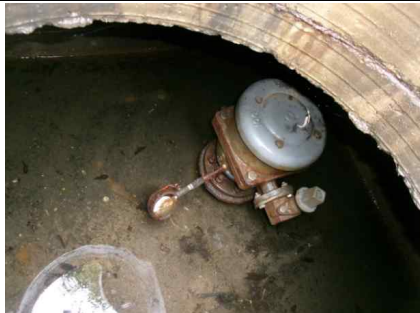
<송수-5 Sta.11+5.2(공기) 구조물 및 밸브 상태양호>
