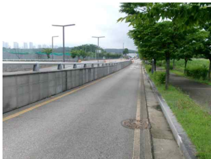
<송수-1, 2 (Sta.1+0.0) 포장 상태양호>
