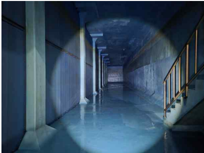
<배수지 3지 전경>
