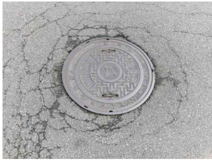
<송수-2 제수밸브실 맨홀 덮개 상태양호>
