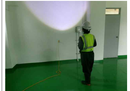
<내부 개별부재 외관조사>
