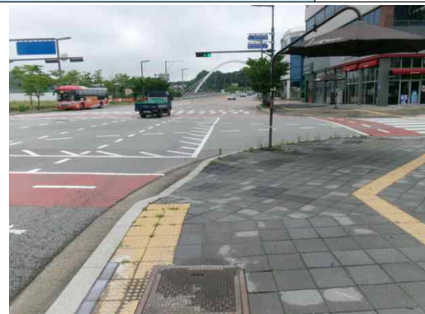
<송수-4, 5 (Sta.315+6.0, Sta.36+16.0) 포장 및 지반 상태양호>
