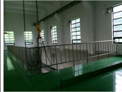
<펌프실 지상1층 안전난간 상태양호>
