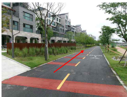
<송수-4, 5 (Sta.282+0.0, Sta.3+10.0)>
