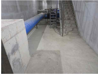
<1~2호지 유입밸브실 바닥슬래브 상태양호>
