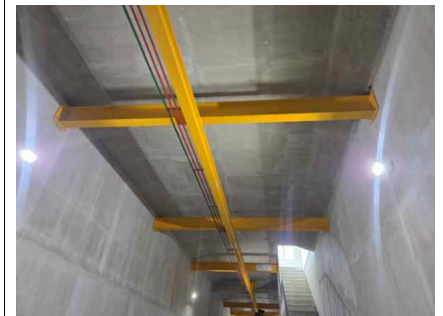
<1~2호지 유입밸브실 상부슬래브 상태양호>
