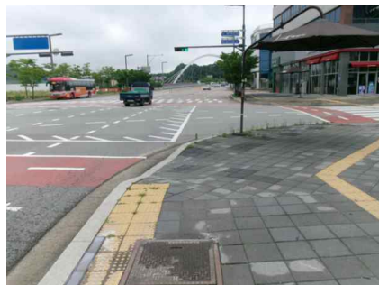
<송수-4, 5 (Sta.315+6.0, Sta.36+16.0) 포장 상태양호>
