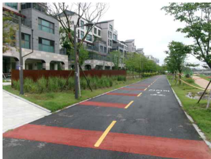
<송수-4, 5 (Sta.282+0.0, Sta.3+10.0) 포장 상태양호>
