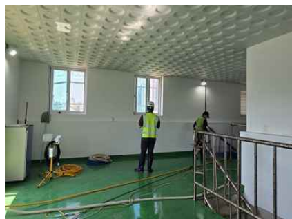
<내부 개별부재 외관조사>
