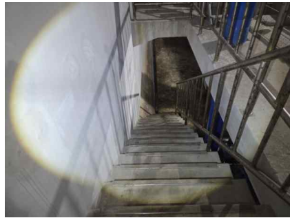
<1~2호지 유출밸브실 계단 난간 상태양호>
