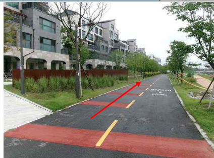
<송수-4, 5 (Sta.282+0.0, Sta.3+10.0) 포장 및 지반 상태양호>
