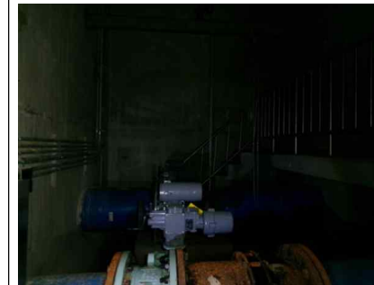
<유입배관실 내부 전경>
