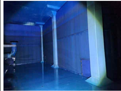
<배수지 4지 도류벽 상태양호>
